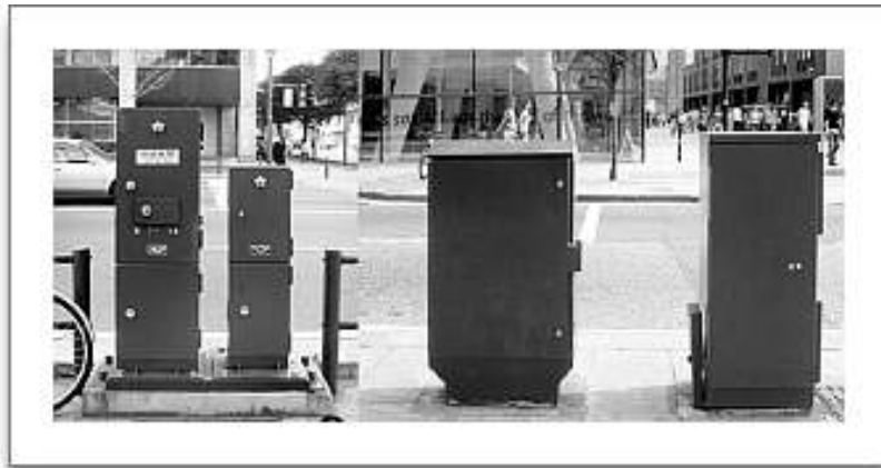
<그림6-10. 모충동 전기 변압기·신호제어기 예시 안>
