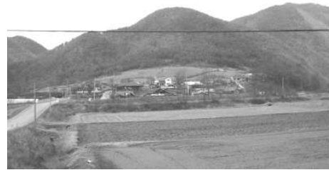
사업전 대상지 마을 전경
